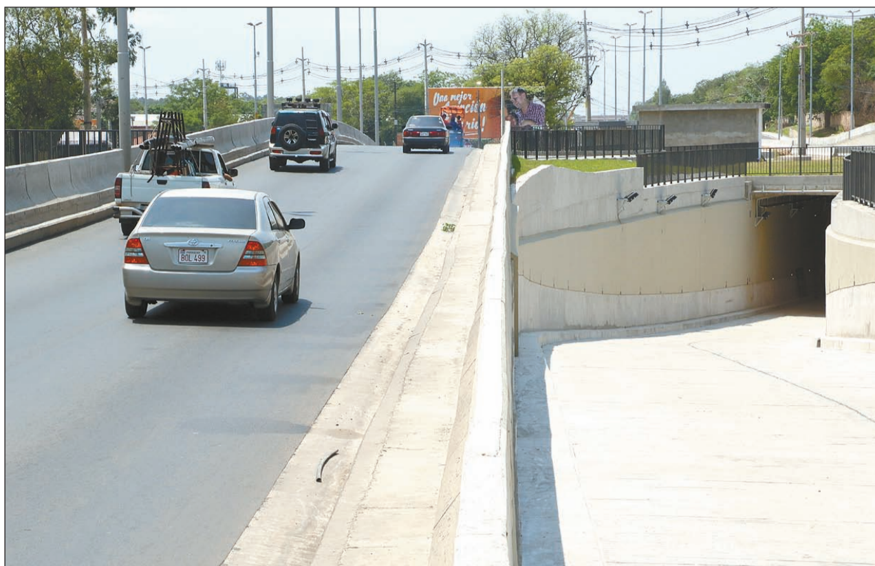
Los trabajos del primer tramo de la avenida Ñu Guasu registran un avance del 98% y prevén terminar a fines de noviembre.
